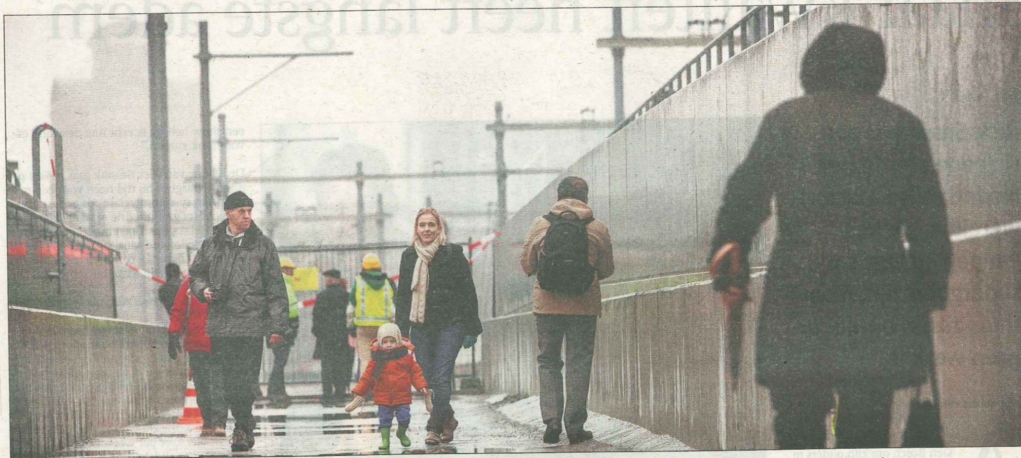
De enkele spoorbrug over de Dieze was zaterdag open voor publiek. Deze week wordt gestart met het aanleggen van rails, wissels en bovenleidingen. foto Maikel Samuels
